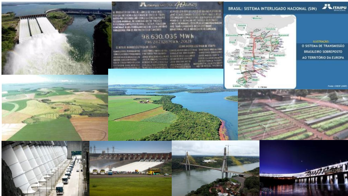
Figura 05-01- A ITAIPU possui potência nominal da usina de 14.000 MW, dividida em 20 unidades geradoras de 700 MW. Supre Energia aos dois Países, com um sistema de Linhas de Transmissão de grande extensão de dimensão análogo ao da Europa. E ITAIPU segue atuando de maneira Sustentável, Preservando a Natureza, apoiando o Desenvolvimento e a Sociedade
