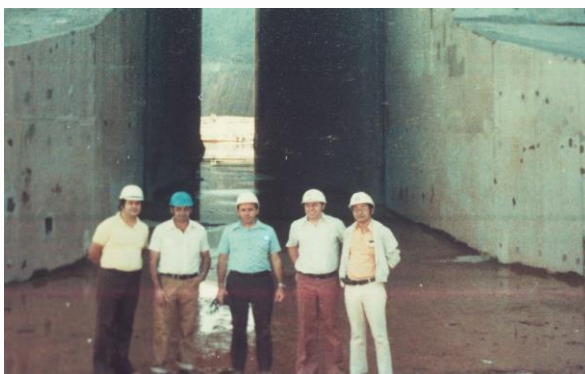
Figura 04-02- Antevéspera do Desvio do Rio Paraná, pelas Adufas em 20 de Outubro de 1978 [08 & 09] . Engos.: José Braga, Ronan, Monteiro, Andriolo, Ademar Sonoda
